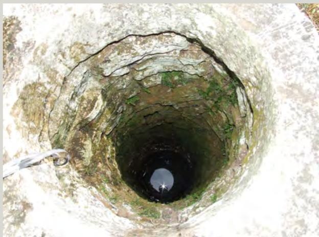
**Miranda** – Pozzo con parapetto, veduta dell'interno. Lungo il perimetro interno del paramento sono state lasciate delle buche a distanza regolare per permettere ad una persona di potervi scendere per le normali operazioni di manutenzione senza adoperare una scala a pioli.
