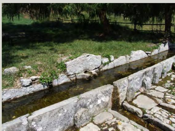
**Staffoli** – Abbeveratoio realizzato in lastre di pietra disposte ad incastro, alimentato da una cannella *pilozza*. Da notare i piedritti verticali in pietra messi a sostegno delle lastre della vasca in corrispondenza di ogni incastro. L'acqua al culmine della vasca defluisce da un incavo in una canaletta di allontanamento realizzata in pietra.
