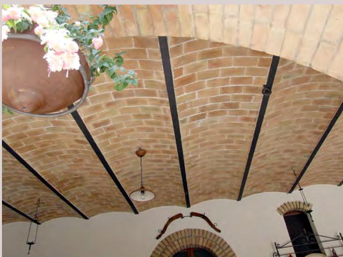
Solaio misto realizzato con putrelle di ferro e voltine di laterizio.
