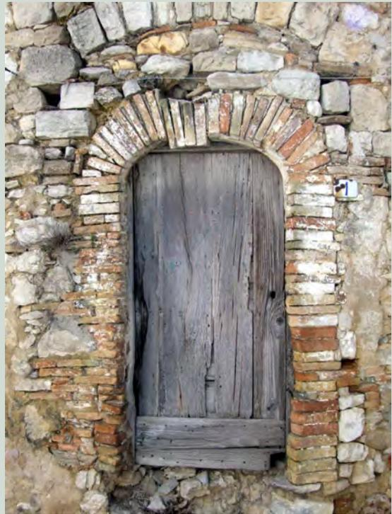
**Palata** - Particolare della porta di accesso. La sconnessione dell'arco del portale è dovuta a dissesti e cedimenti della struttura portante.
