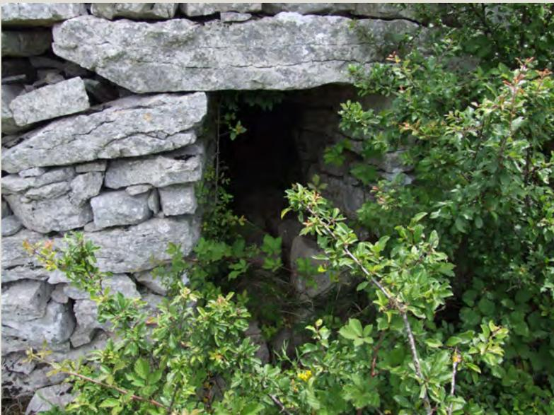
**Miranda** - Varco di trullo con particolare dell'architrave in blocco monolitico.
